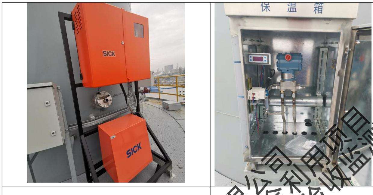
陕西精益化工有限公司委托陕西铎鑫环境检测技术有限公司每季度对硅铁炉烟气进行在线比对，比对监测内容包含颗粒物、氧含量、湿度、流速、烟温。废气在线比对监测 2021 年第三季度比对结果见表 4.2-17，比对监测报告见附件 8。根据比对监测结果锅炉烟气排放口比对监测颗粒物、氧含量、湿度、流速、烟温比对监测结果均符合 HJ75-2017《固定污染源烟气（SO<sub>2</sub>、NO<sub>x</sub>、颗粒物）排放连续监测技术规范》标准规定的要求。
